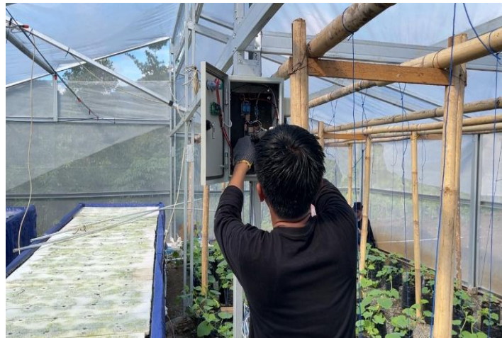
Gambar 2. Proses Instalasi Panel Kontrol Sistem Iot Pada Greenhouse Kelompok Tani Bukit Lumbu
