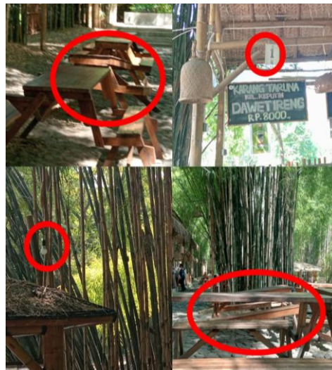
Gambar 4. Fasilitas Pasar Sorpring yang Memerlukan Perbaikan
