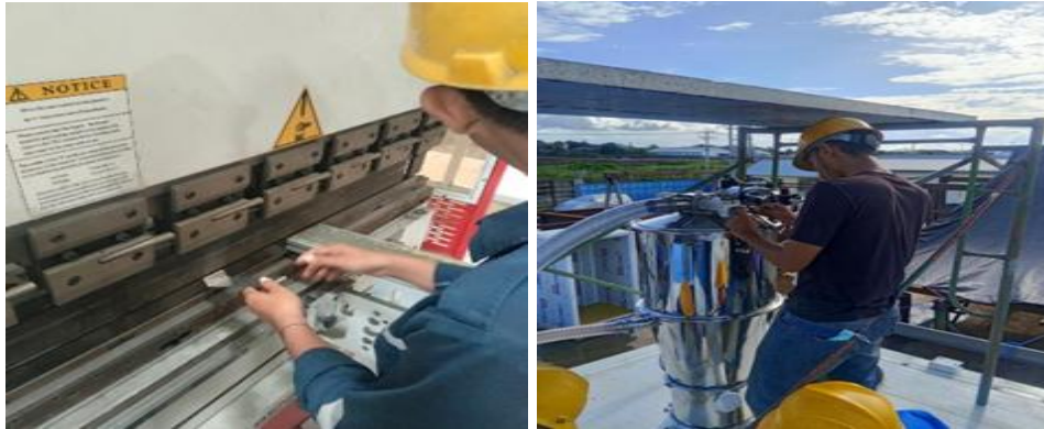
Gambar 2. Bending Support Tray Cable dan Instalasi Kabel pada Junction Box
