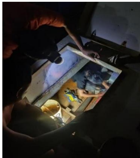
Gambar 3. Pemasangan Injection Pump di Kapal AJP 02
