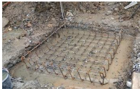
Gambar 2. Pemasangan Tulangan Pondasi Tapak
