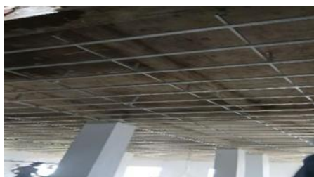
Gambar 1. Pemasangan Besi Hollow
