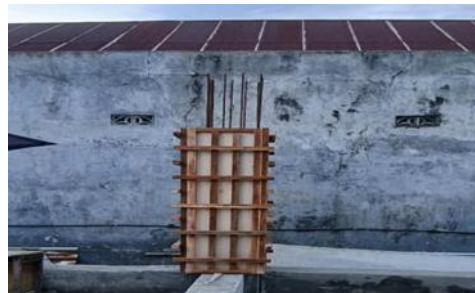
Gambar 4. Pemasangan Bekisting Kolom
