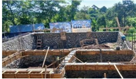
Gambar 5. Pengecoran Sloof
