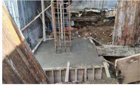
Gambar 3. Pengecoran Pondasi Tapak
