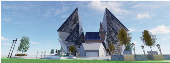
Gambar 10 Tampak Depan Bangunan [7]
